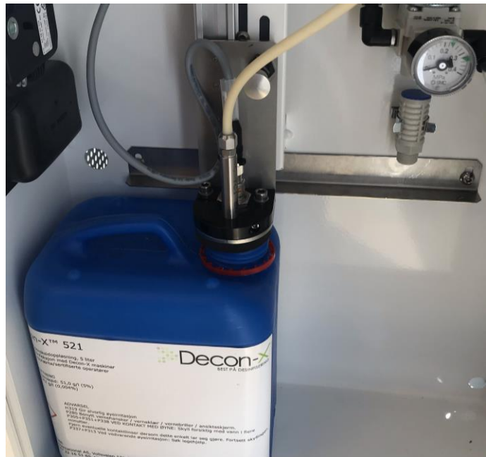
Figur 19: Korrekt montert kjemikanne
